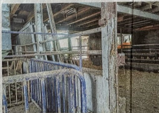
In dem bisherigen Rinderstall in Stahle sollen zehn Einstellplätze für pflegebedürftige Pferde und Esel eingerichtet werden.
